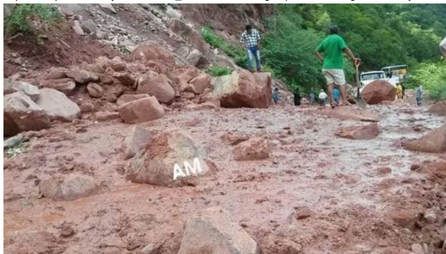
DERRUMBES EN EL ANGOSTO DE TARIJA
